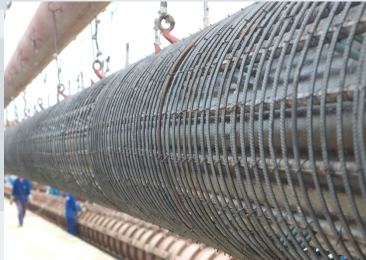
ESTACAS DE FUNDAÇÃO
